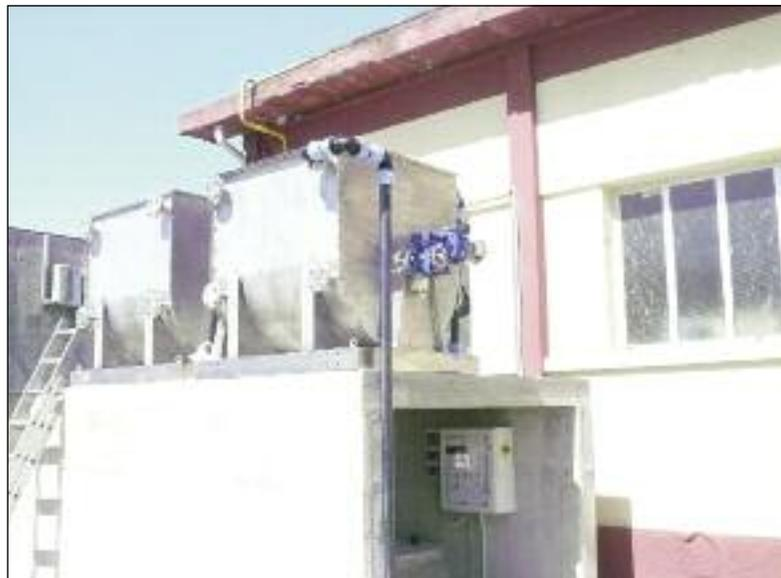
motore elettrico ed all'uso dei tappi, dato che il biofilm batterico ottiene ossigeno per svolgere il proprio lavoro dalla rotazione del sistema in atmosfera e non mediante compressori dedicati».
